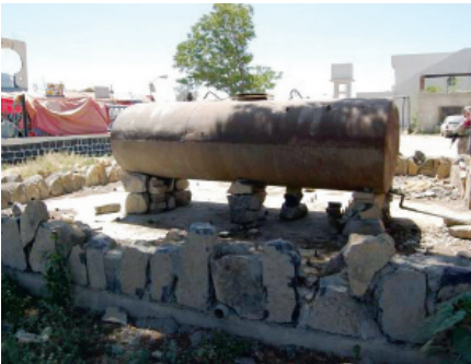
از یک تانک پوسیده مواد سوخت که بر روی سنگ ها قرار دارد به جای تانک 6000 لیتری جدید مواد سوخت در فابریکه تولید برق 2 شهر خوست استفاده می شود. این تانک ها باید بر اساس طرح ریزی پروژه نصب می شدند. (عکس SIGAR)
