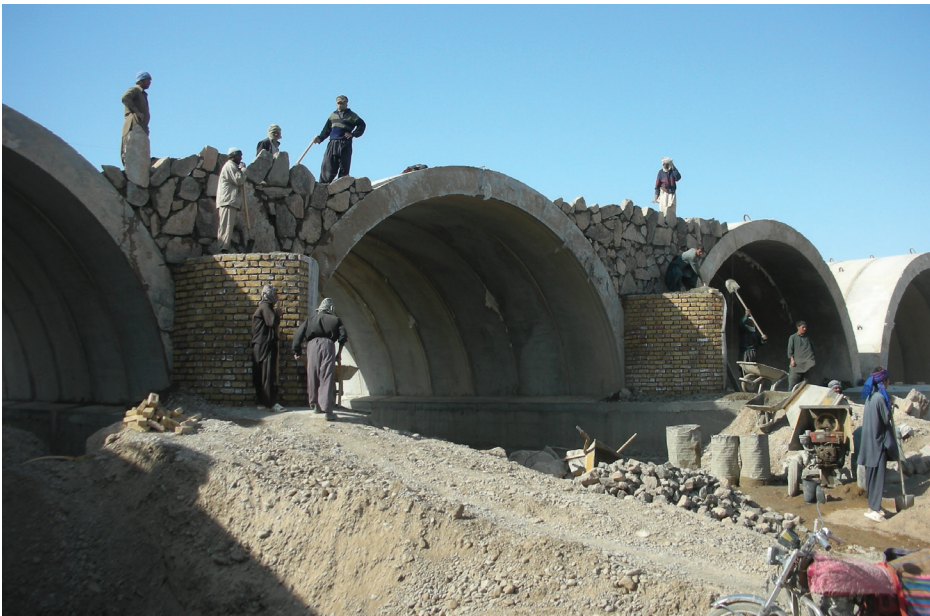
کارگران افغان در حال محکم کردن پایه های نگهدارنده پل تاج بالای رودخانه فراهم هستند. سرمفتش خاص برای بازسازی افغانستان اسنادی از نظارت مدیریتی و کنترل کیفیت پروژه های معوق در اختیار دارد. (عکس SIGAR)
