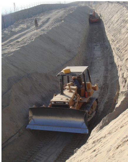
یک قراردادی افغان در حال حفز یک خندق ضد-موتور در اطراف سربازخانه اردوی ملی افغانستان در گمبیری است که از آن به عنوان مجرای تخلیه گندآب نیز استفاده می گردد. (عکس SIGAR)
