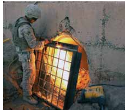
یک تیم قوای بحری ایالاتمتحده در افغانستان یک سیستم ممانعت از ورود به آبگذر نصب میکند. (عکس وزارت دفاع)
