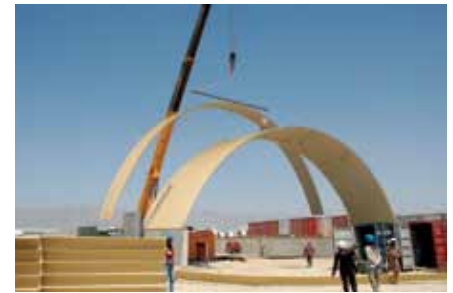
کارگران یک ساختمان K-Span در میدان هوایی بگرام اعمار می کنند. (عکس اردوی ایالات متحده)
