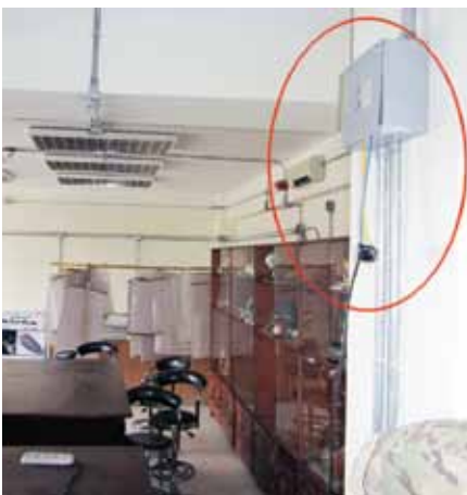
سیم کشی برقی نامناسب و سرکت های برقی دچار اضافه بار (که با حلقه سرخ رنگ نشان داده شده اند) باشندگان مکتب شبرغان را در معرض خطر حریق و شاک الکتریکی قرار می دهند. (عکس SIGAR)
