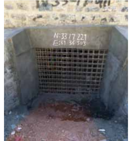
سیستم های ممانعت از ورود به آبگذر مثل این شبکه میله های فولادی مانع از جاسازی آسان آلات انفجاری در زیر جاده ها می شوند. (عکس SIGAR)
