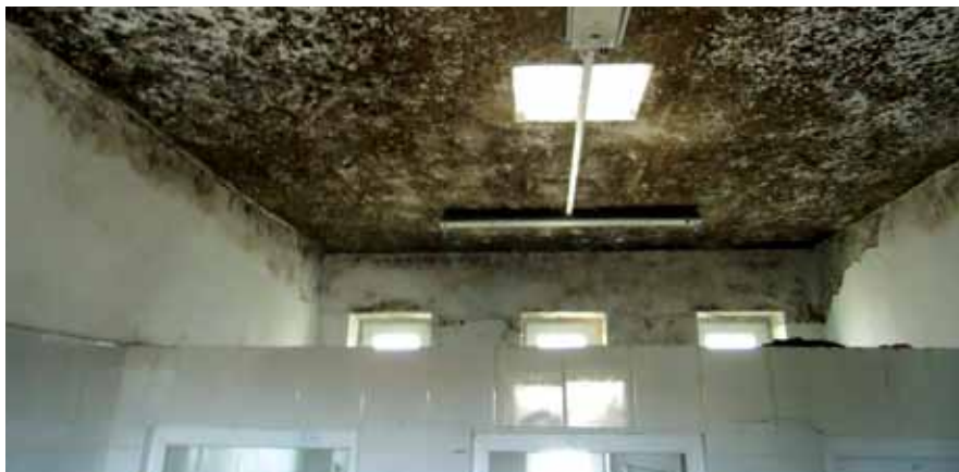
قوماندانی پولیس ساحوی آرچی حاوی پوپنک های خطرناک بر روی دیوارها و سقف تأسیسات رهایشی/وظیفوی حدود 40 نفر از نفرات پولیس ملی افغانستان است. (عکس SIGAR)
