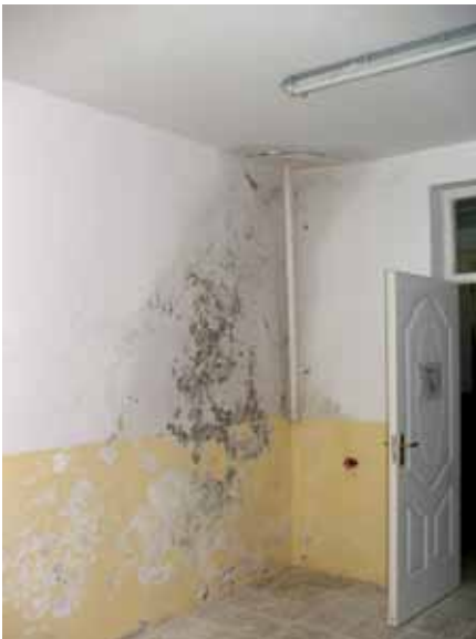
سقف شفاخانه سالنگ چکک میکند و منجر به ایجاد پندیده گی روی سقف و دیوار شد است. (عکس سرمفتش خاص بازسازی افغانستان توسط براین فلین)
