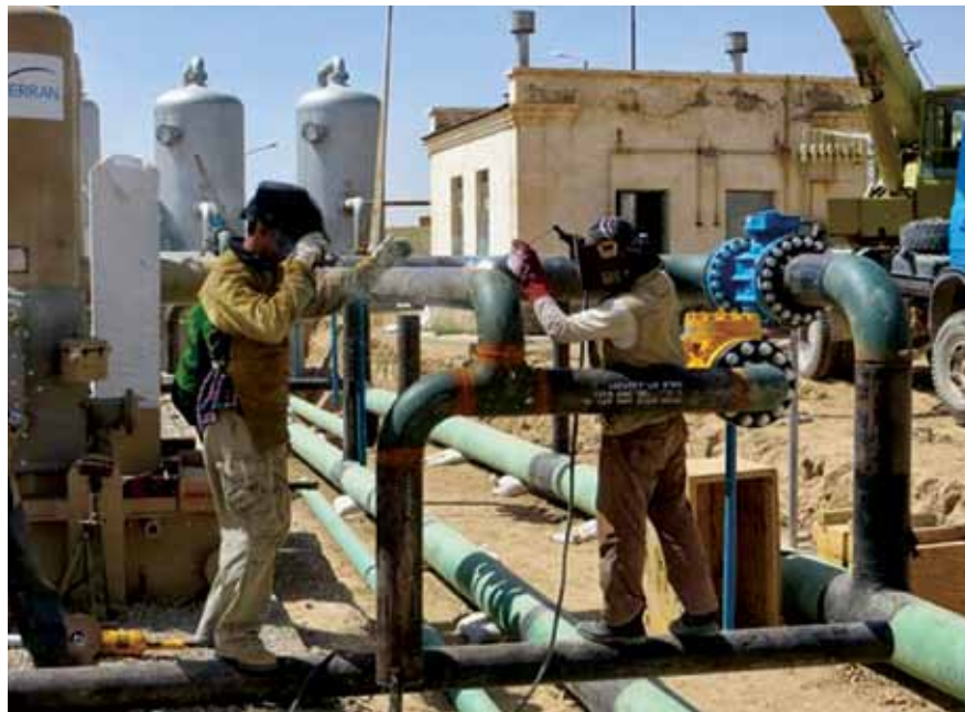
کارگران، پایپ کمپریسی را که یک بخش از پروژه احیای پایپ لاین شبرغان است، ولدینگ میکنند. (عکس TFBSO)
