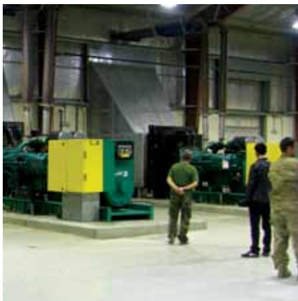
تفتیش SIGAR آشکار کرد که جنراتورها، مانند آنچه در تصویر دیده میشود، به درستی به ترانسفارمر وصل نشده اند و همین موضوع به دو ترانسفارمر آسیب زده است. (عکس SIGAR توسط برایان فلین)
