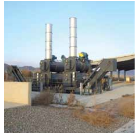
دو زباله سوزهای با ظرفیت بلند بیکاره انداخته شده در FOB سالیمو. (عکس سیگار توسط آدریل حراری)
