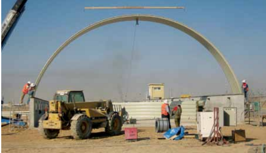
آغاز ساخت و ساز ساختمان در یکی از تاسیسات اردوی ملی افغانستان. (عکس توسط قوای هوایی ایالات متحده)
