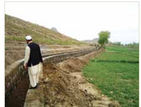
یک پروژه Sika در کانال شرقی در ولایت پکتیا در ماه می 2015. (عکس USAID)
