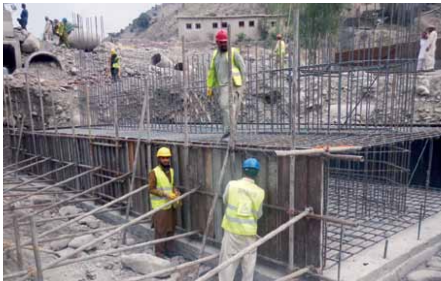
کارگران در حال ساخت پایه پلی هستند که قسمتی از پروژه احیاء مجدد سرک گردیز-خوست میباشد. (عکس USAID)
