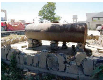
یوه د تېلو ټنګ شوی ټانکی چې په تیرو پرته ده د خوست د ښار د برېښنايي پلانټ ۲ لپاره د زیرمي په توګه کارول کېږي په ځای د هغو دوو نویو ۶،۰۰۰ لیټره ټانکیو چې د پروژې د ډیزاین سره سم باید لګول شوي وای. (د سیگار انځور)
