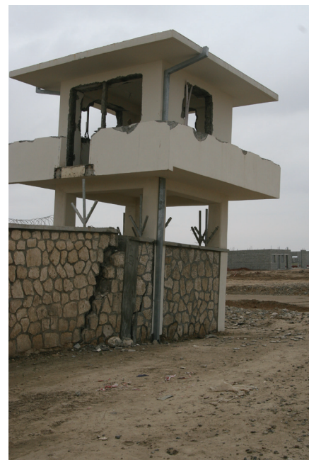
د خاورې سخت خرابوالی د دې سبب شوی چې دا د ځوکېدارۍ ځای وښوېږي او ترې چاپېرو دېوالونو کې درزونه وشي. سیگار په دې وروستیو کې د کنډوز د افغان ملي اردو د مرکز د جوړېدو په ځای کې د خاورې د ثبات مهمې ستونځې پېژندلې دي. (د سیگار انځور)
