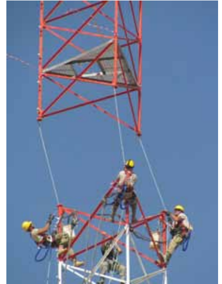
د متحده ایالاتو په بگرام کې د هوایي ځواک یوه فني ډله د راډیويي مخابراتي د کچې د پراختیا په موخه د ۱۷۰ فوټ مخابراتي سکشنونه سره تړي. (د متحده ایالاتو د هوای پوځ عکس)
