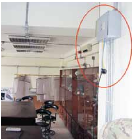
ناسمه لین دوانی او زیات بریښنايي سرکټونه (سره حلقه ترې تاوه شوې) د شبرغان ښوونځي استوګنو په وړاندې د اورلګیدنې او بریښنايي شاک خطرونو ته اشاره کوي. (د سیگار انځور)
