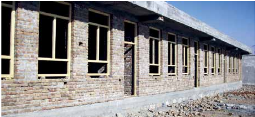
يو ښوونځي په بت خاک کې چې د پلاستيکي کرکيو او د قرارداد په اساس د بلوکونو د ديوالونو په ځای د لرګيو له کرکيو او د څښتو له ديوالونو څخه جوړ شوی. (د سيکار عکس)
