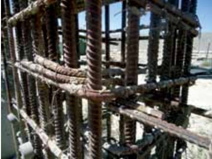
د پروان عدلیې مرکز کې لویدلو خطر: ویلډینګ په ځای له ویرونوڅخه کار اخیستل شوی. (سیکار عکس)
