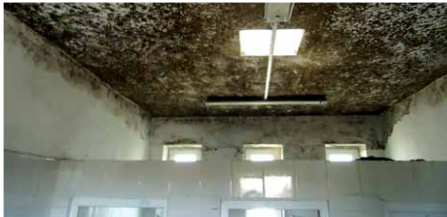
د آرچي ولسوالۍ پولیسو قرارگاه قوماندانۍ د نږدې 40 ملي پولیسو کارکوونکو د ژوند او کار تاسیساتو په دیوالونو او چتونو باندې خطرناکه چناسکې لري. (سیگار عکس)
