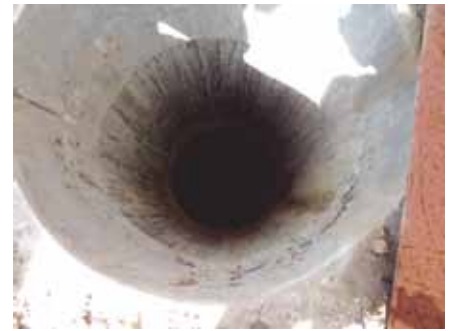
د سپټیک څخیرې لاره نه د چوډن اوسپنې پوښ لري نه هم یوه دایمي زینه لري، پداسې حال کې چې دواړه یې د قرارداد په شرایطو کې راغلي دي. (د سیگار تصویر د مایک-ټین-کیت لخوا)
