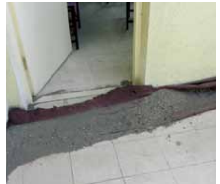
د سیگار پلټونکو د دویم چټ داسې یوه کتاره ومونده چې د صف دروازې خوا ته میلان لري، او د دې لپاره چې د باران اوبه له دې لارې څخه تویې نشي یو مانع ته اړتیا لري. (د سیگار تصویر د لیس نامسن لخوا)
