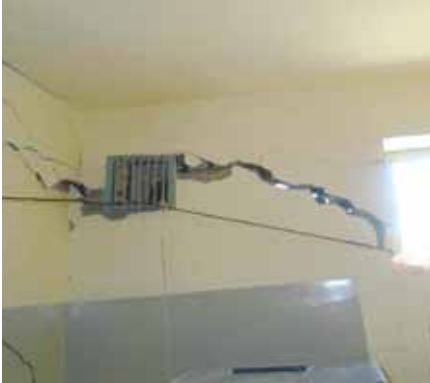
د بغلان د بندیکخانې په 17 ودانۍ کې د ځمکې خاورې ناسته د ودانۍ په ساختمان کې د ناوان او بیا د رنگولو سبب شوې. (د بهرنیو چارو وزارت تصویر)
