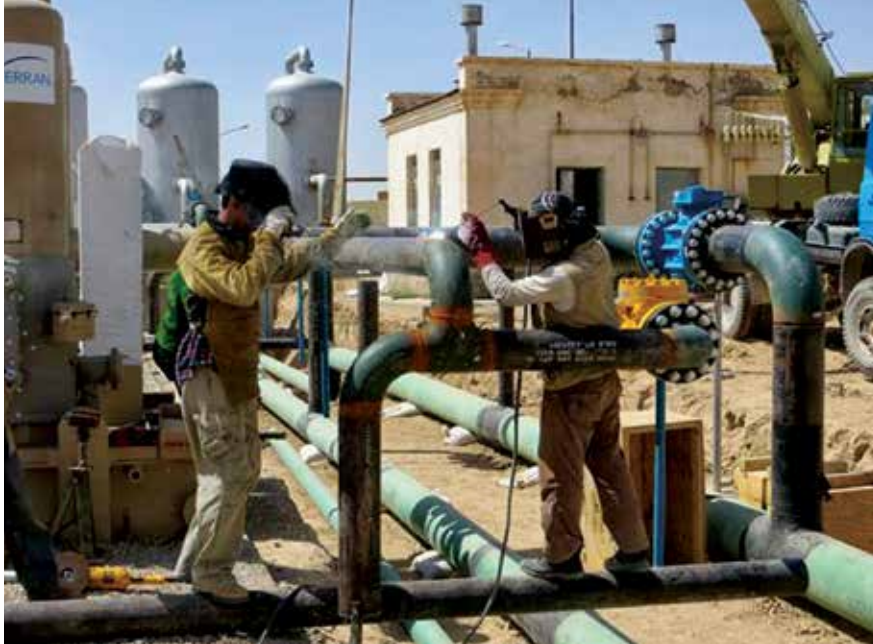
کارگران د کمپریسور یو پایپ ویبر کوي چې د شبرغان پایپ لاین له سره جوړونې پروژې برخه ده. (د TFBSO عکس)
