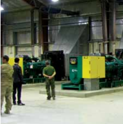
د سيگار تفتيش وموندل چې جنريټرونه لکه څنگه چې عکس اخيستل شوی، ترانسفرمر سره غلط وصل شوي و، چې دوه ترانسفرمر ته د زيان اوبنتو لامل شو. (د سيگار عکس د بريان فلين لخوا)
