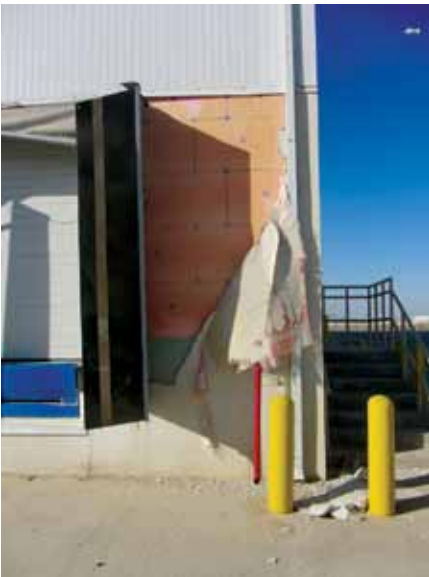
د سیگار له خوا د کندهار په هوايي ډګر کې د یوه ساتنځي پلټنې په تعمیراتي برخه کې د ودانې د بهرني پلستر د ماتېدنې په شمول ګڼ کوچني عیبونه وموندل. (د سیگار عکس چې رونالد سنډر اخیستی دی)
