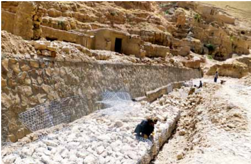
د Sika لویډیز سپانسر شوی د سیلابونو څخه د محافظت دیوال په بادغیس ولایت کې د ټولني لخوا جوړېږي. (د USAID عکس)
